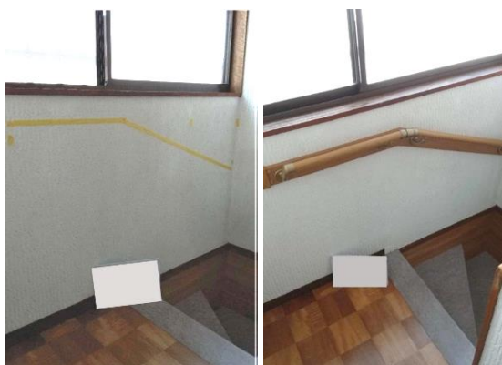
▲階段手摺設置前
